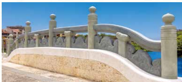
復元された「世持橋」
